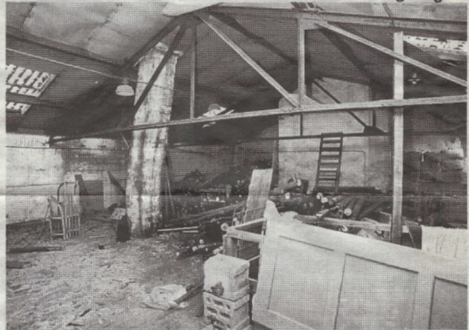
„Am Anfang war die Erde wüst und leer“: Auf dem Dachboden türmt sich noch das Gerümpel – auch dieses Areal wird bei der künftigen Sanierung in einen Saal mit Galerie integriert. Bild: Stephan Huber
