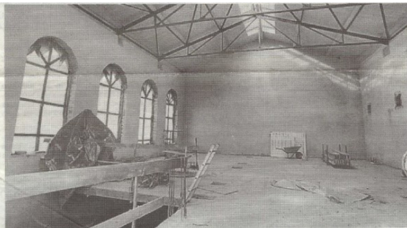
Blick in die größere Halle II, die erst im Rohbau fertig ist. Hier wird im kommenden Jahr das Planungsbüro Meiller/Dittmann u. Partner einziehen. Bild: Huber
