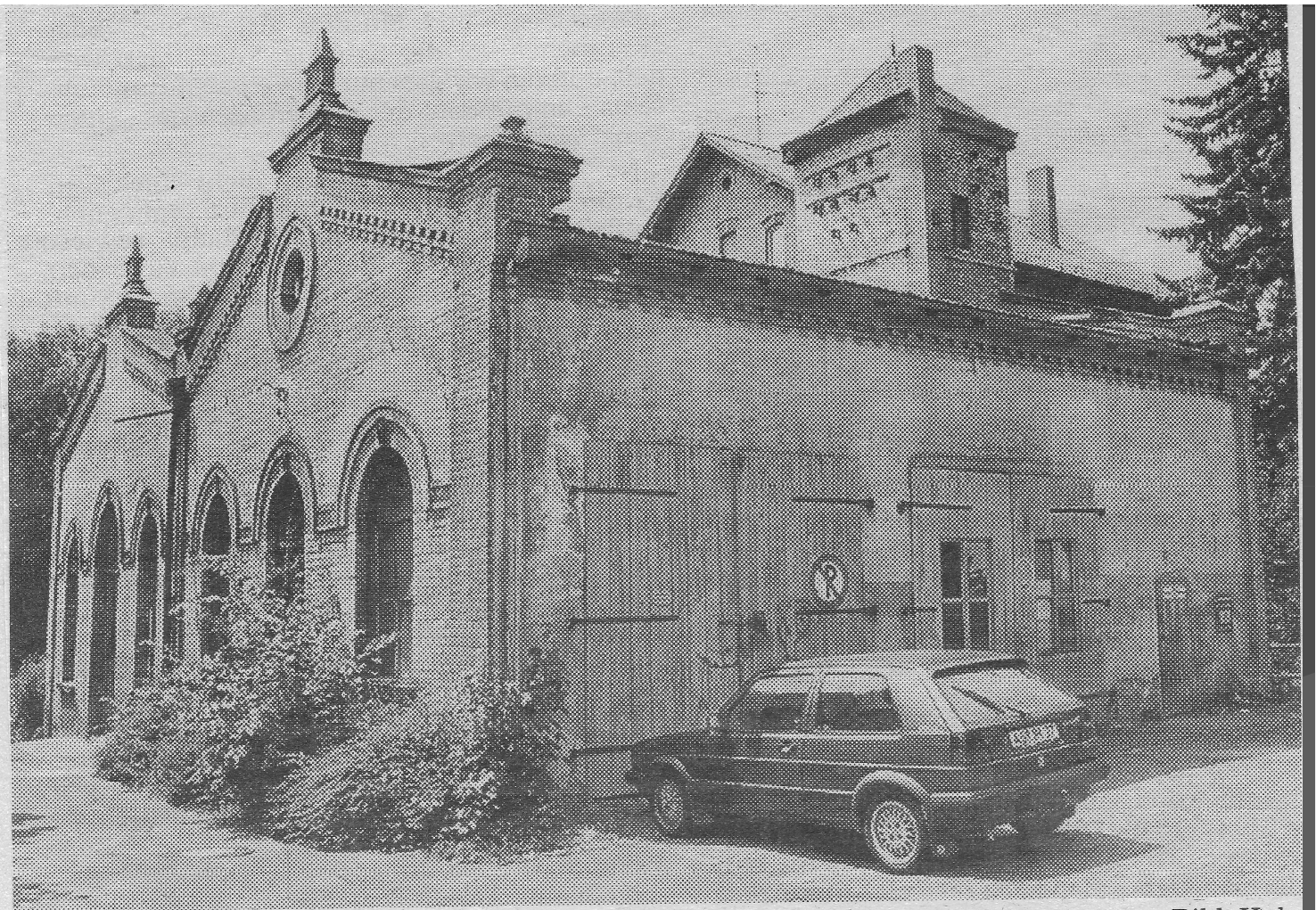
Millionenschweres Sanierungsobjekt: Das alte E-Werk in der Weiherstraße.
